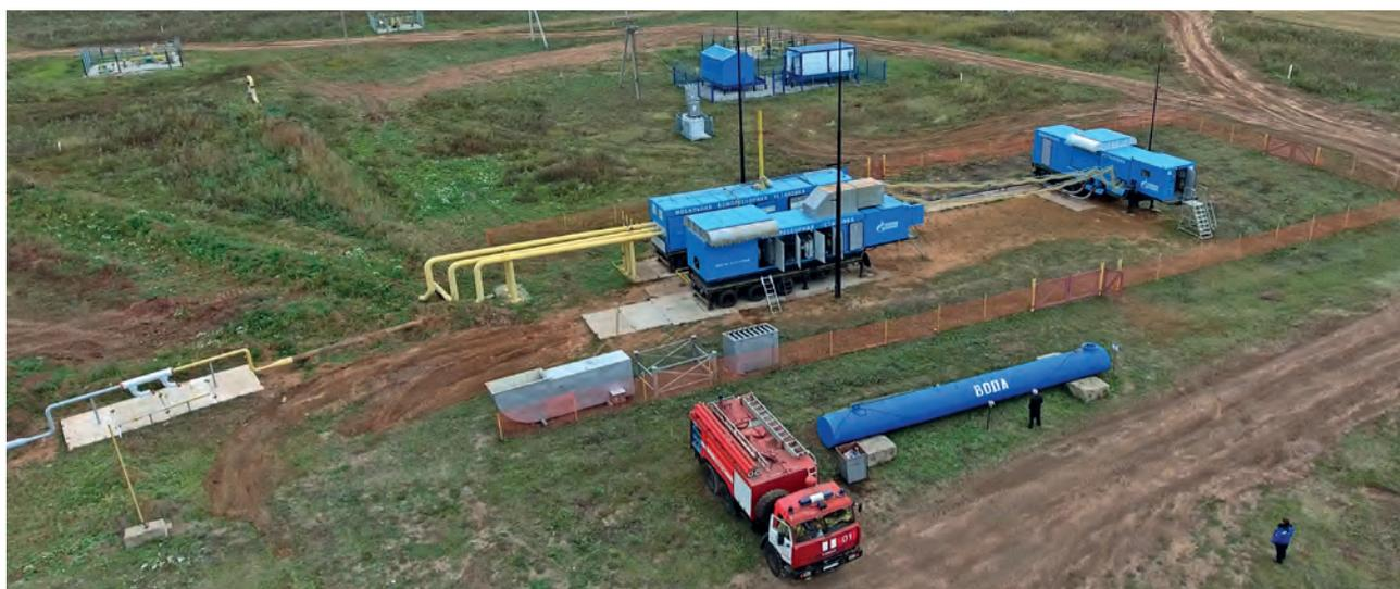
Рис. 1. Мобильная компрессорная станция с газотурбинным приводом «МКУ-МТ/ГП»
