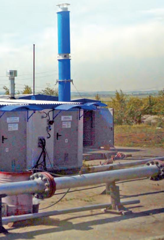
ческой энергии, использующим поток природного газа. Данное устройство позволяет АГРС НП быть полностью энергоавтономной и работать без присутствия оператора, что особенно важно, если объект удален от крупных городов и тех мест, где есть линии электропередачи.
